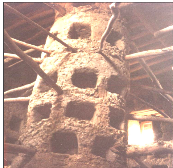
تصویر ۱۰. ستون خشتی (برج میانی) کبوترخانه سمت راست (مأخذ: آرشیو میراث فرهنگی آذربایجان غربی).
