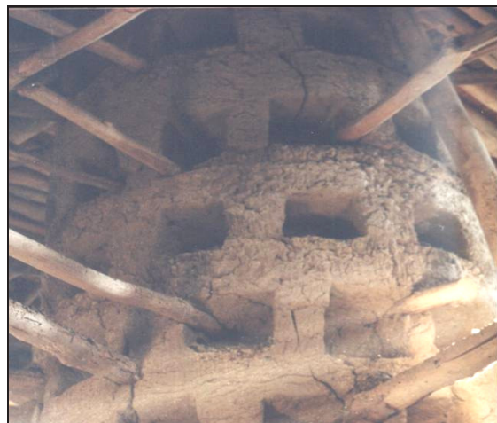
تصویر ۹. ستون خشتی (برج میانی) کبوترخانه سمت چپ (مأخذ: آرشیو میراث فرهنگی آذربایجان غربی).
